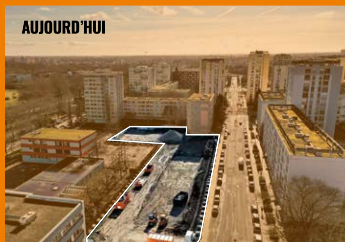
Espace libéré par la démolition du 32-42 avenue du Lac
