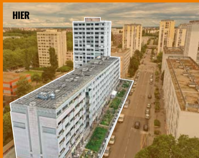
Emplacement du 32-42 avenue du Lac avant sa démolition
