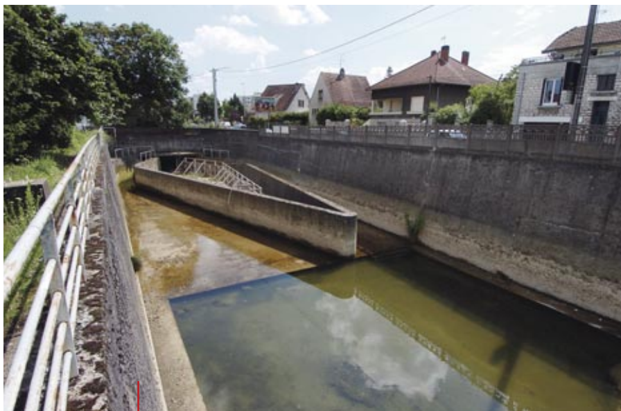
L'ouvrage de couverture de plus d'un kilomètre comporte trois canaux de sections différentes traversant la ville, avec des débits variés. Au centre, l'égoût collecteur ; sur la rive gauche, le conduit qui se dirige vers le canal Saint-Nicolas qui emprunte l'ancien tracé de la dérivation dite des « Vieux-Terreaux » (à gauche sur la photo) ; sur la rive droite (à l'ouest et à droite sur la photo), celui qui, à partir du cours Fleury, traverse le centre-ville pour aller se jeter dans l'Ouche, à hauteur de la place du 1 er -Mai.
