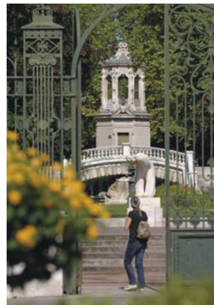
Le réservoir Darcy est situé dans le jardin du même nom.
