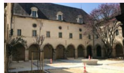
Le cloître du monastère des Bernardines qui accueille le musée de la Vie bourguignonne a été réaménagé au mois d'avril.
